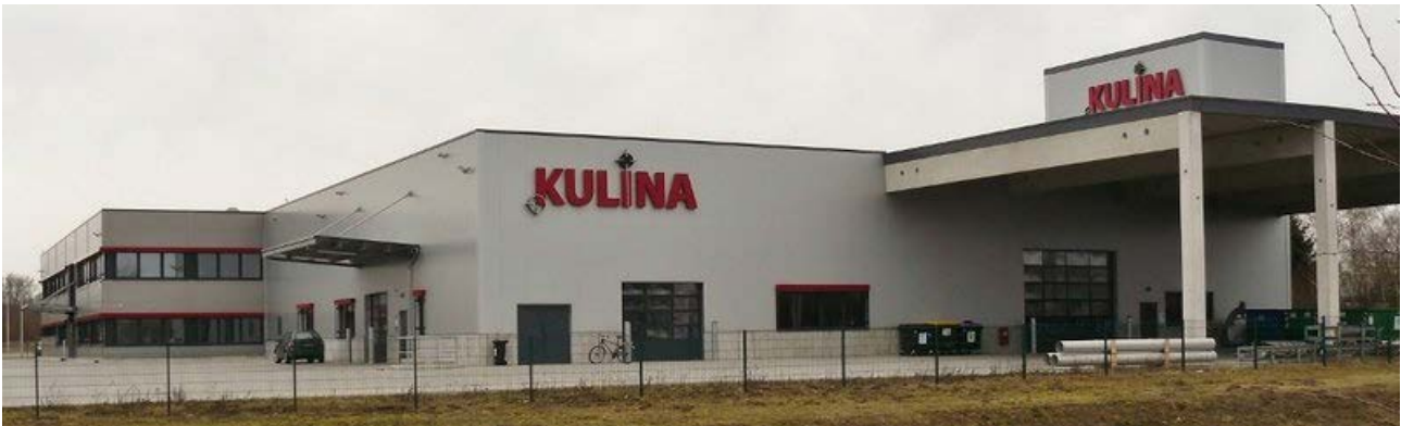
Der Neubau der Kulina GmbH mit Solaranlage auf dem Dach
