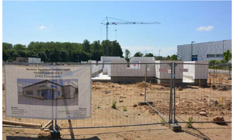
Umzug im September: Derzeit entstehen Büro- und Werkstattgebäude.
