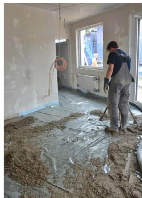
Der Estrich für die neuen Büro- und Sanitärräume kam Ende August.
